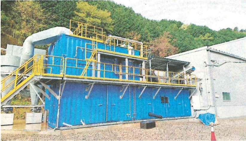
蒸気を発生させる小型回転燃焼炉RPFボイラー。関市洞戸飛瀬、秋田屋フーズ洞戸工場
